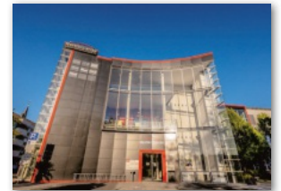
Im Nestler-Areal ist das seit 50 Jahren bestehende Unternehmen IMA Immobilien ansässig.
