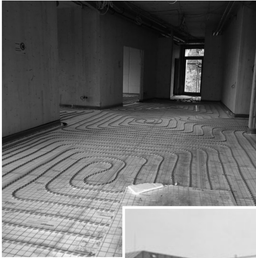
Installation der Fußbodenheizung in der neuen Kita.
