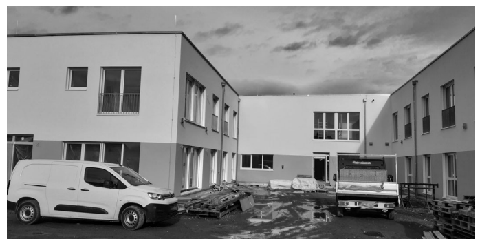
Der Hinterhof des "Haus Taubergießen". Später wird hier eine Terrasse entstehen.
