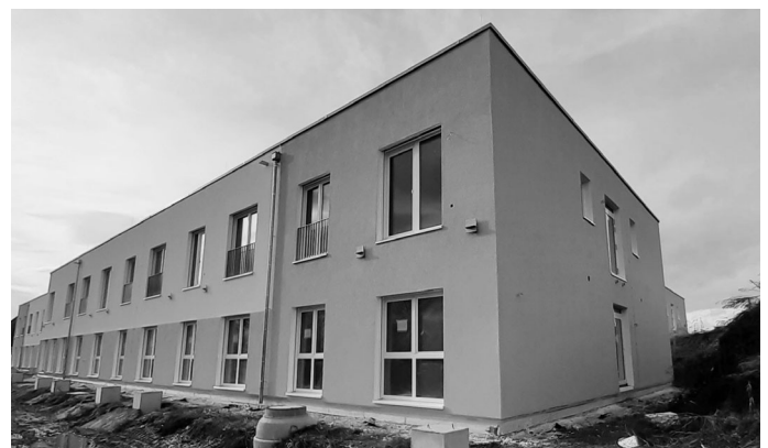
Im Frühsommer 2021 werden die letzten Arbeiten am "Haus Taubergießen" abgeschlossen.
