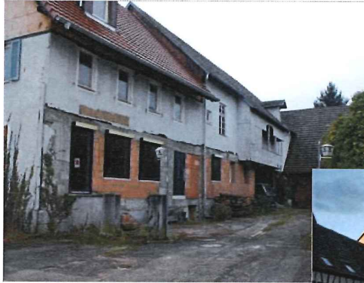
Umbau und ergänzende Bebauung innerhalb der historisch gewachsenen Bebauung (eigene Fotos)
