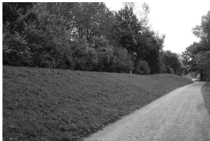
Der bestehende Hochwasserdamm VI südlich der Landesstraße L 103
